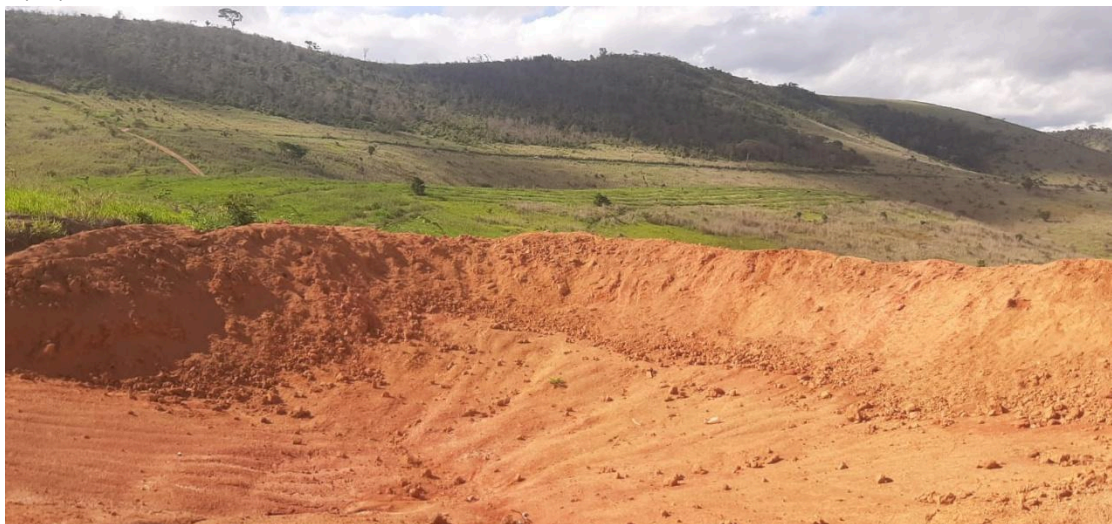
Figura 17. Barraginha construída para a perenização da água. Autoria: Marina Bahia. Data: 26/11/2024.
