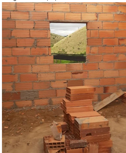
Figura 26. Casa de apoio em obra. Autoria: Lucas Rodrigues. Data: 26/11/2024.
