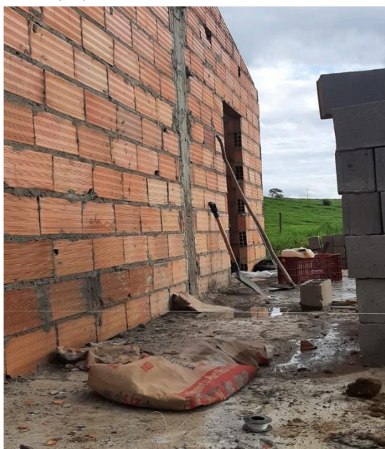
Figura 25. Casa de apoio em construção. Autoria: Lucas Rodrigues. Data: 26/11/2024.
